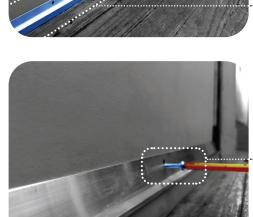
انتهى التركيب! إن تثبيت سدادات الهواء عنع الهواء الدافئ من التسرب من منزلك ويقلل دخول الهواء البارد، ويساعد ذلك على . خفض تكلفة التدفئة في فصل الشتاء
